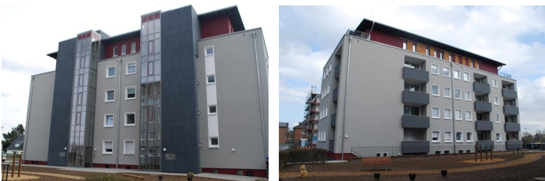
Ansichten der Pestalozzistr. 6 – 8 nach Fertigstellung
